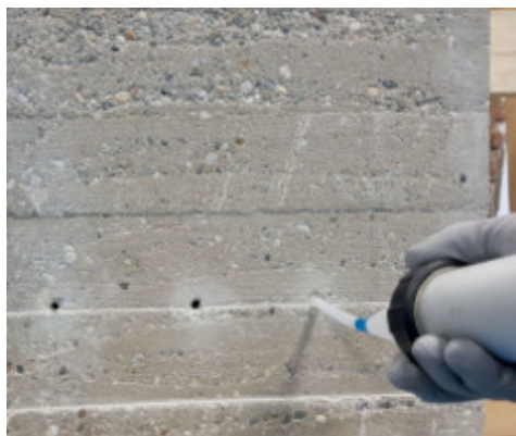
Realizzazione barriera chimica in parete in CLS
