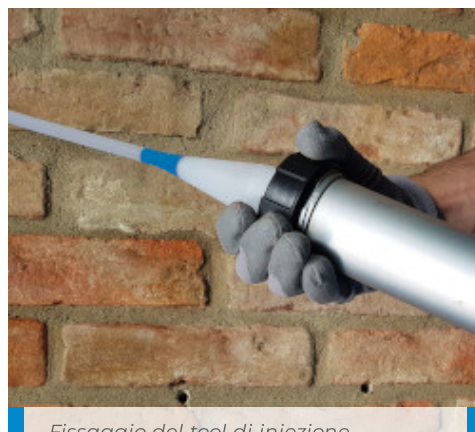
Fissaggio del tool di iniezione avvitando la ghiera alla pistola
