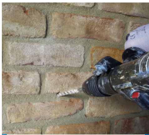
Realizzazione dei fori
