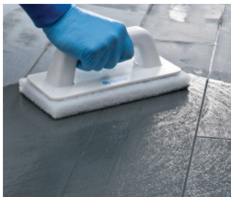
Pulizia delle fughe con Scotch-Brite® (a prodotto parzialmente indurito)
