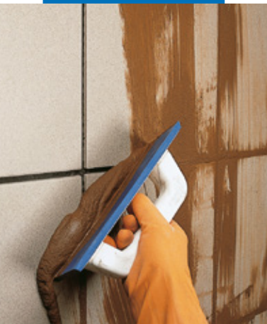
Stuccatura di rivestimento esterno con spatola
