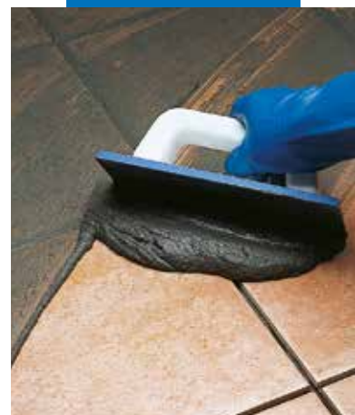
Stuccatura di monocottura con spatola
