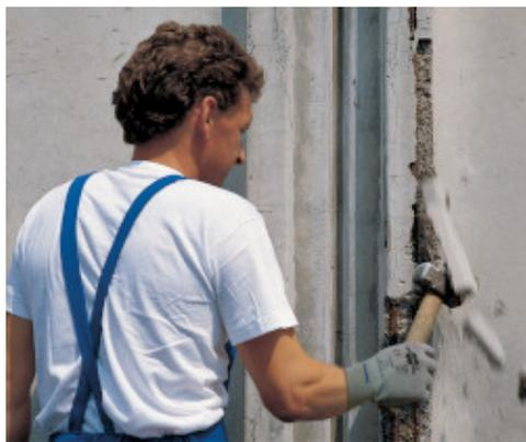
Demolizione del calcestruzzo degradato
