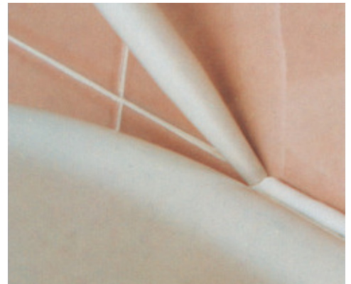
Sigillatura di sanitari
