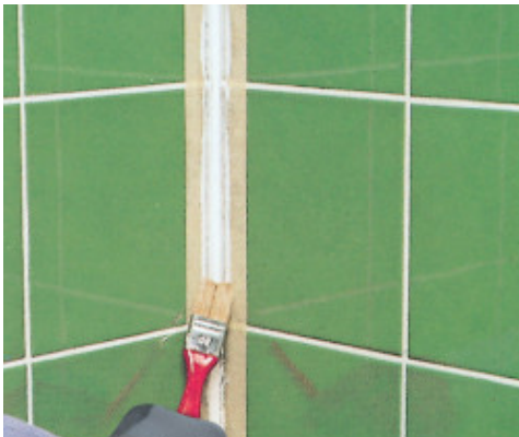
Lisciatura del giunto con acqua saponata a pennello
